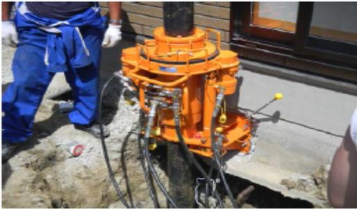
① 専用機で鋼管杭の打ち込み
